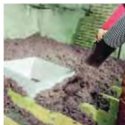
6 L'application par soufflage est performante. Les flocons de laine passent partout. C'est la fin des ponts thermiques, trop fréquents lors d'une isolation en rouleaux et l'assurance d'isoler toute la surface des combles.
