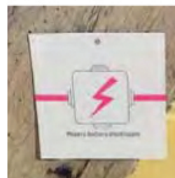
4 Traitement des dispositifs électriques, boîtiers de dérivation, spots, transformateurs...
