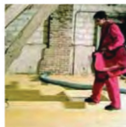
3 Repérage du chantier
